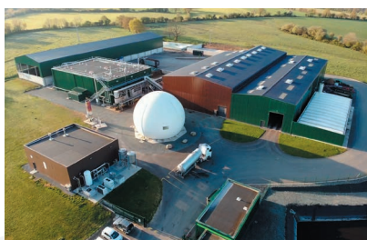
Méthanisation Gazteam Energie Combrand - 2018
