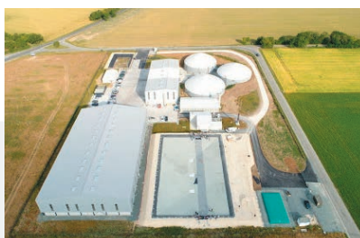
Méthanisation Aunis Biogaz Surgères - 2019
